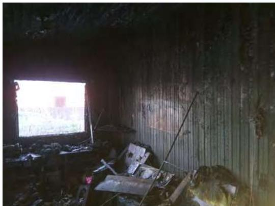
В результате пожара повреждена кровля на площади 20 м<sup>2</sup> и веранда на площади 40 м<sup>2</sup>. Предварительная причина пожара – нарушение правил монтажа электрооборудования.
